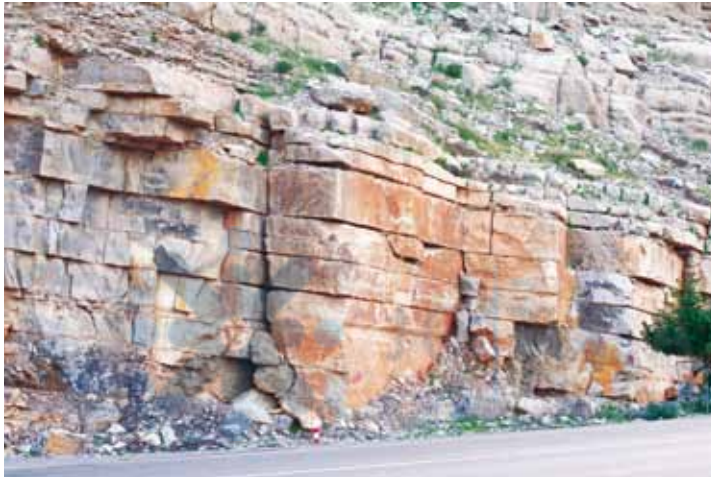
الشكل رقم (٣-١٢): الشقوق وأثرها في إضعاف الصخر.
